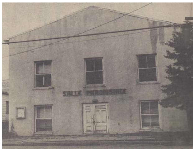
Salle paroissiale construite en 1913 située au village
